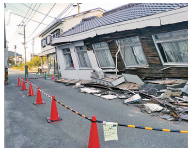
インフラ復旧が望まれる現場
